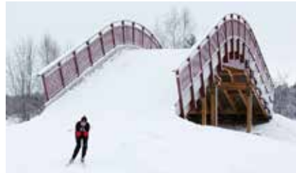
Bild 1 (s 23): Bild från Lycksele skidstadion. Foto: martinsons.se
